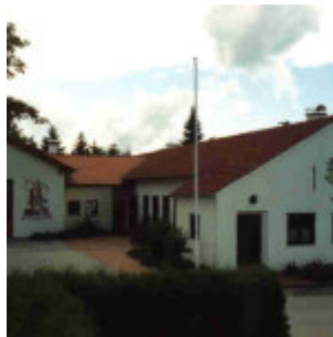
Neues Gerätehaus mit Schulungsgebäude
