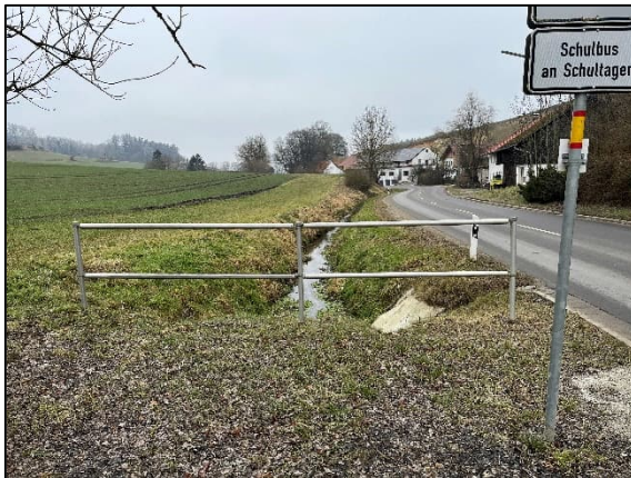
Wolfsbach Ortsende, in Fließrichtung
