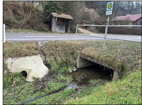
Verrohrung Wolfsbach (Rechteckprofil)
