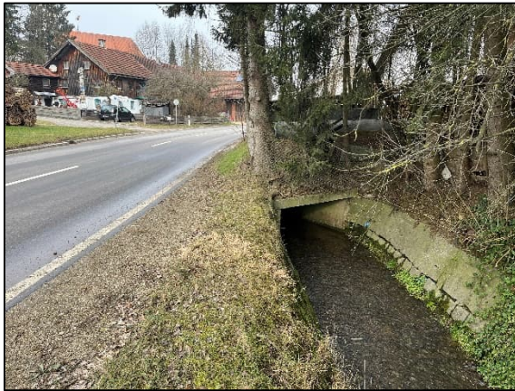
Verrohrung (Rechteckprofil) Wolfsbach Fl.-Nr. 533/2
