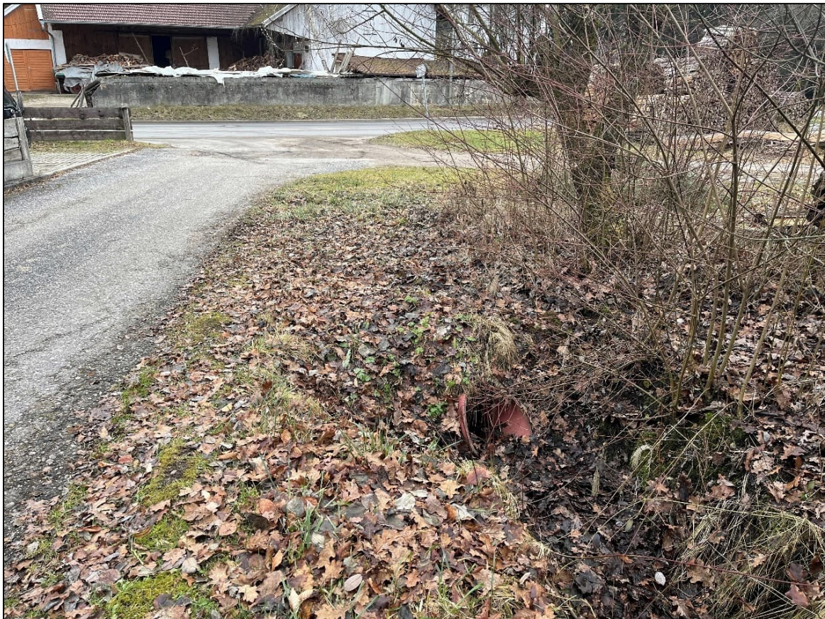
Abbildung 7: Foto Einlauf DN 400 in verrohrten Wolfsbach
